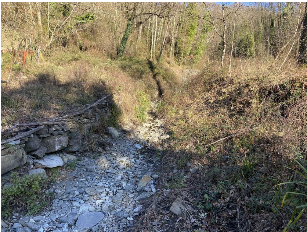
Foto 12. Attività di Survey, fraz. Gorga. Stio (SA). Orientamento foto: S/E. (Coordinate: 15.23358,40.31772)
