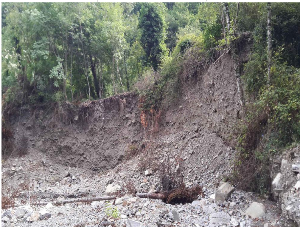
Foto 4. Attività di Survey, fraz. Gorga. Stio (SA). Orientamento foto: E. (Coordinate: 15.23286,40.32182)
