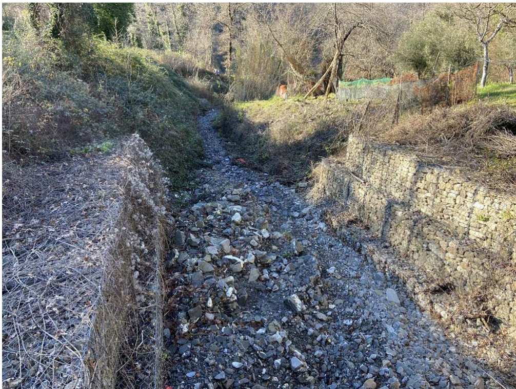
Foto 11. Attività di Survey, fraz. Gorga. Stio (SA). Orientamento foto: E. (Coordinate: 15.23269,40.31922)
