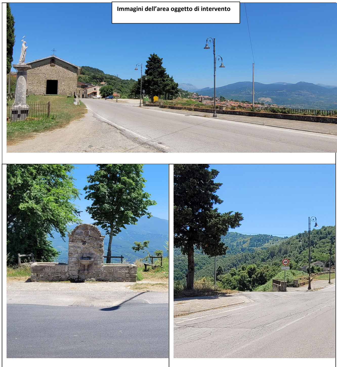
Fig. 4: scatti area oggetto dei lavori
