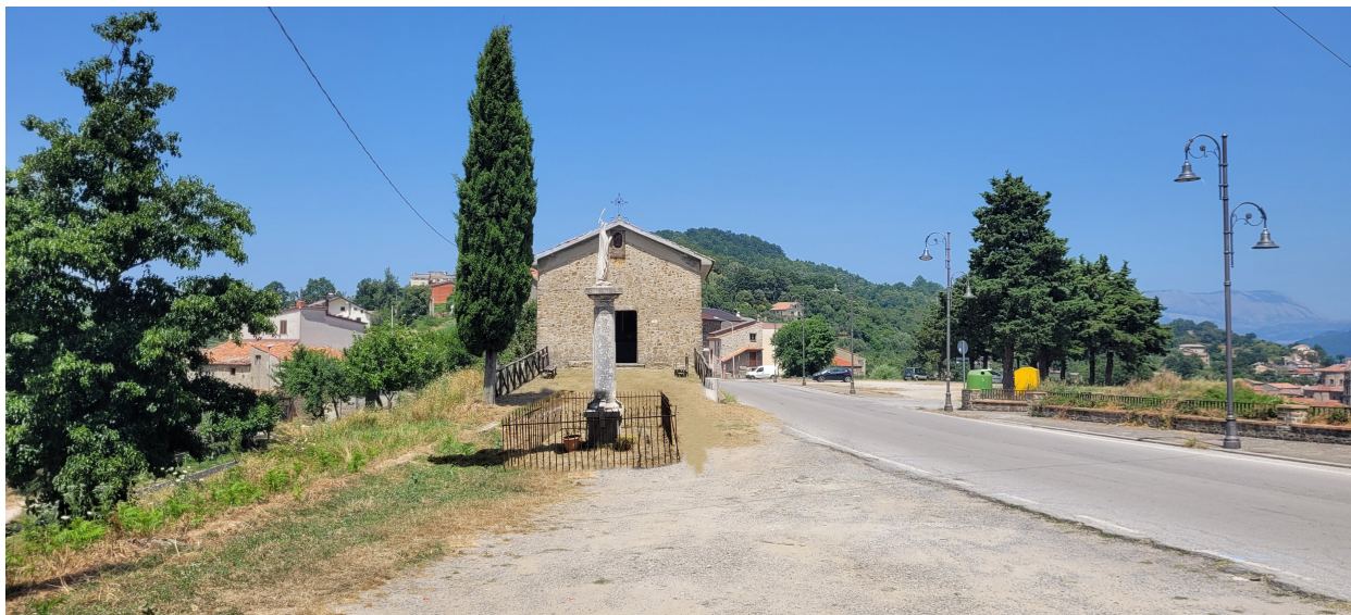
Stato di fatto – Cappella di Santa Maria della Croce
