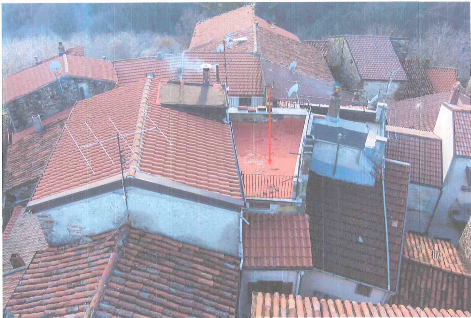
Foto n°3 terrazza di copertura e tetti vari
