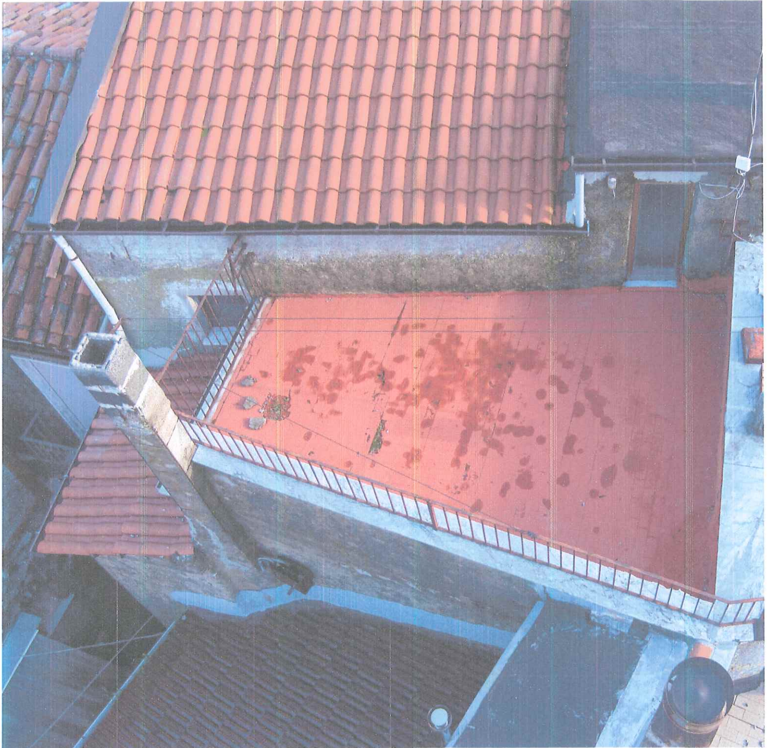
Foto 2 – Terrazza di copertura
