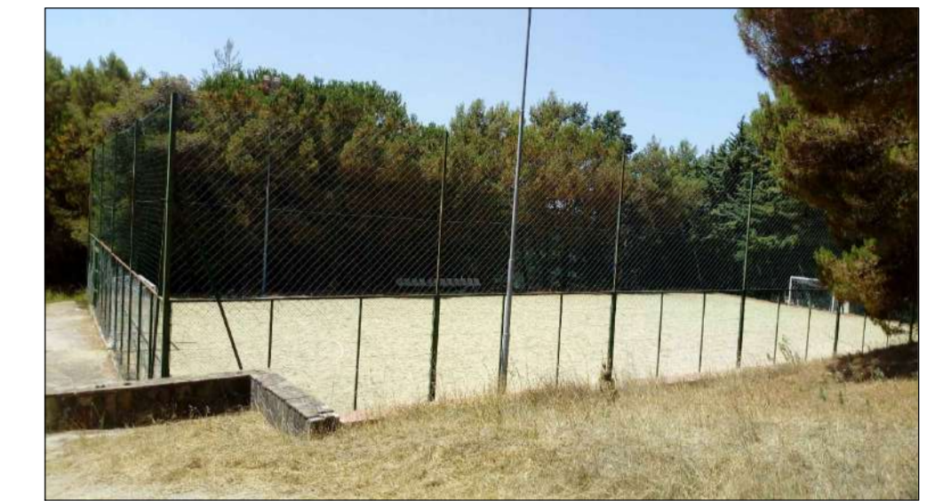
CAMPO DI CALCETTO: vista del campo dall'area a verde
