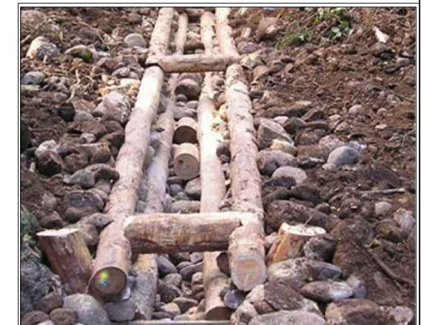
Cunetta di scolo in legno e pietrame
