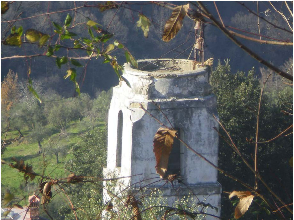
Particolare copertura e della cella campanaria
