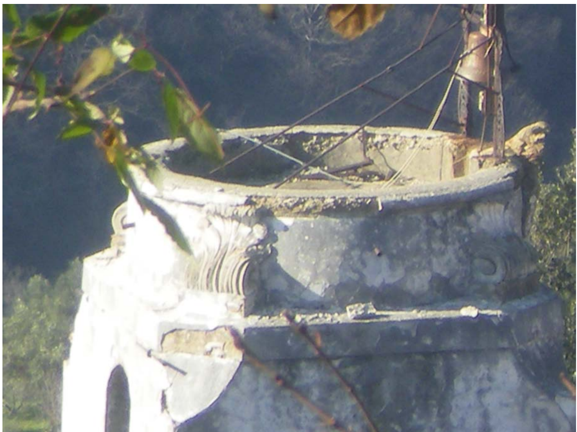
Particolare anello di coronamento della copertura
